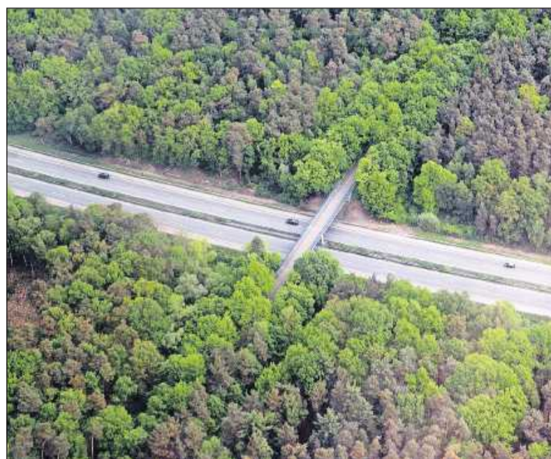
Noch ist die Grünbrücke nicht zu sehen: Diese soll rechts neben der Brücke entstehen und den Tieren helfen, sicher die Autobahn zu überqueren. FOTO: LENZ
